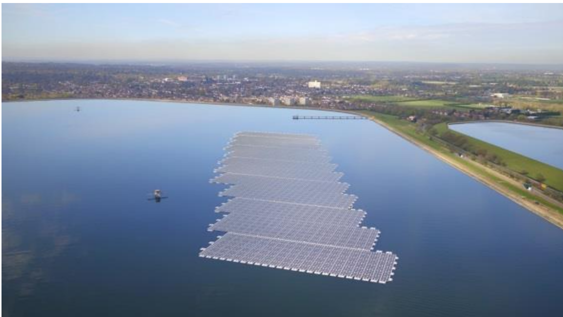
Abbildung 37: Schwimmende PV Anlage in UK Quelle: https://www.lightsource-re.com
